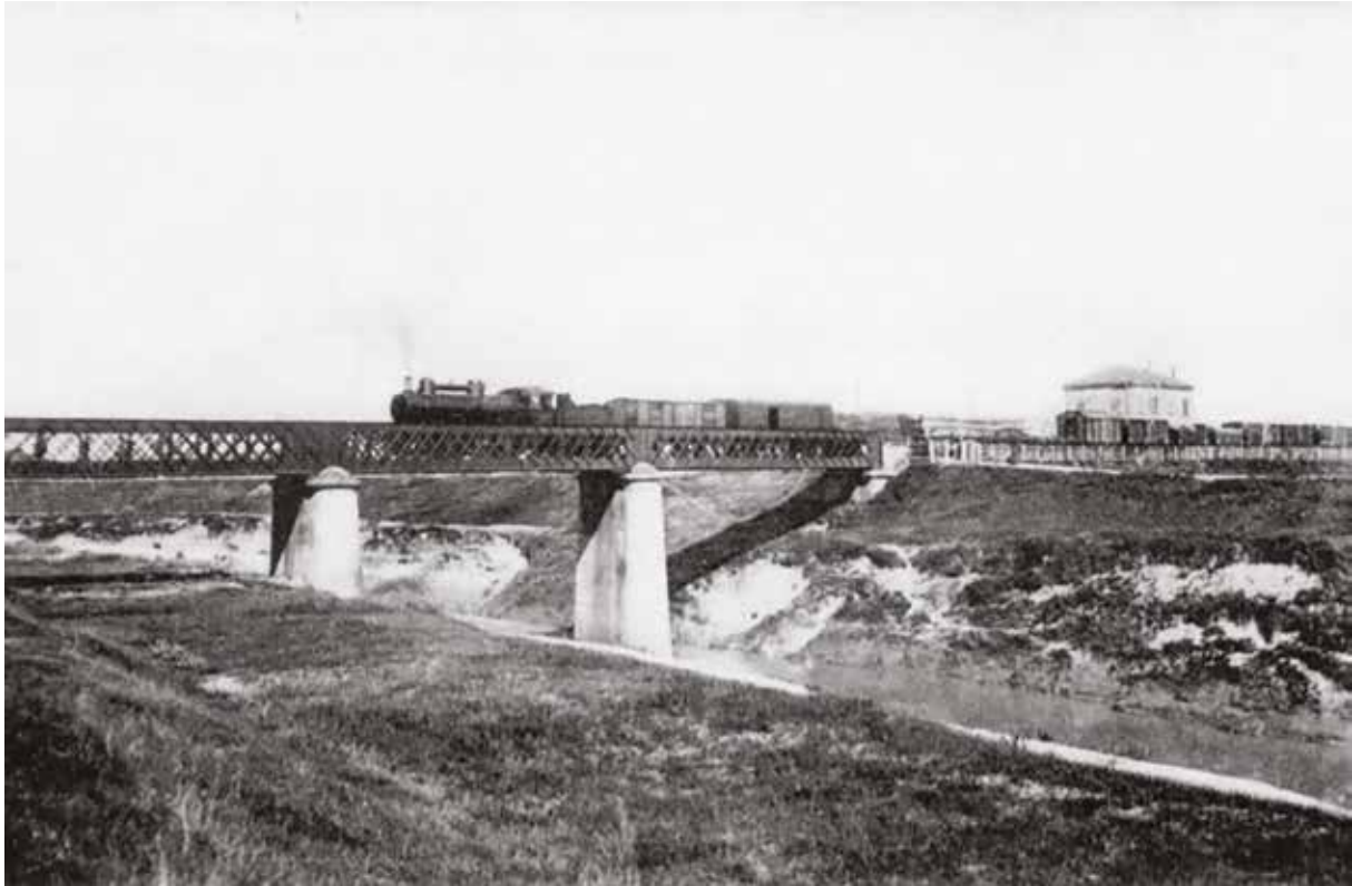
Ponte ferroviario negli anni '20-'30 del Novecento, visto dal versante bolognese
