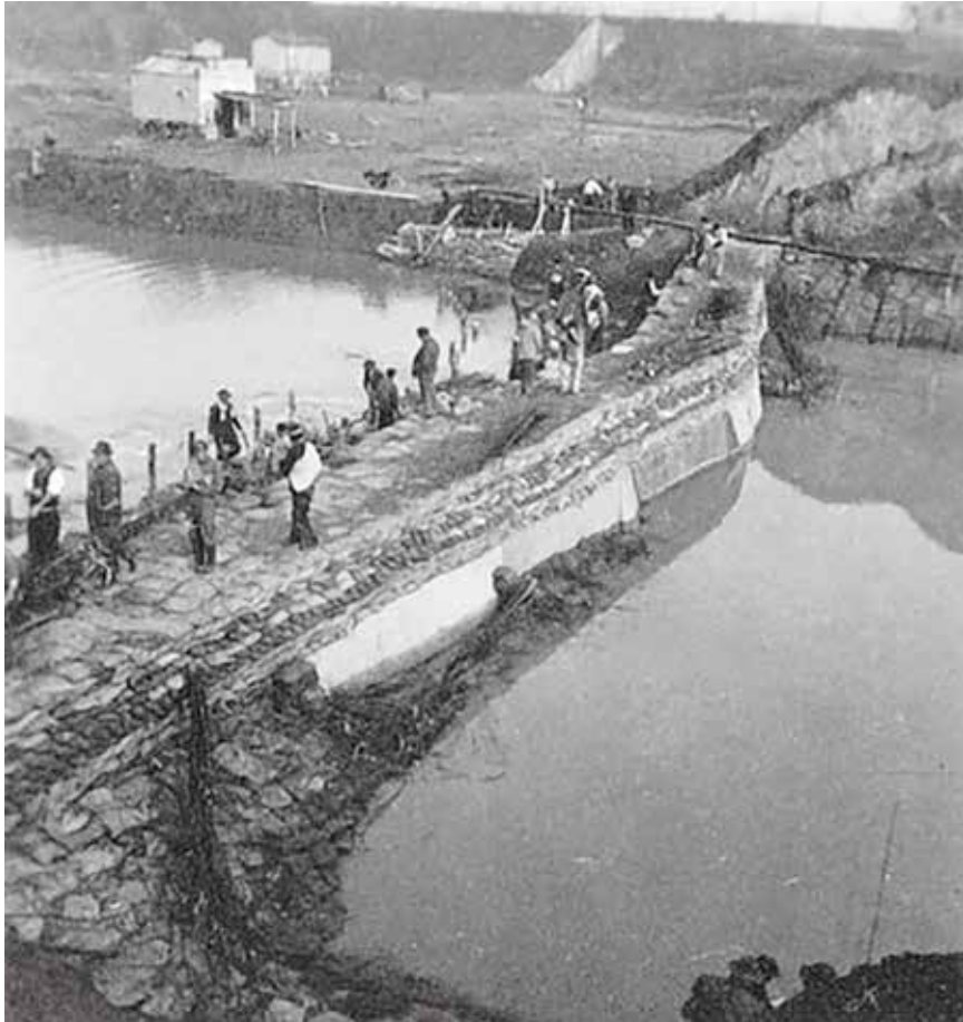
Alluvione del 1952: la coronella provvisoria ultimata
