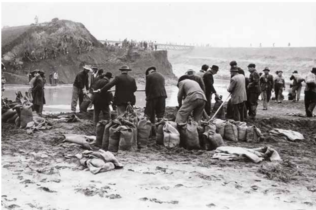
Alluvione del 1952: i primi tamponamenti
