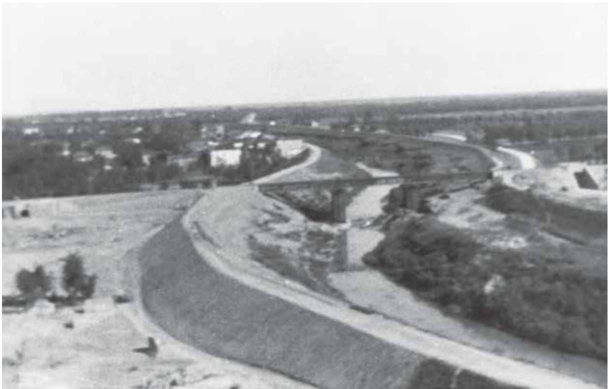
Alluvione del 1952: ripristino arginale completato (estate 1953)
