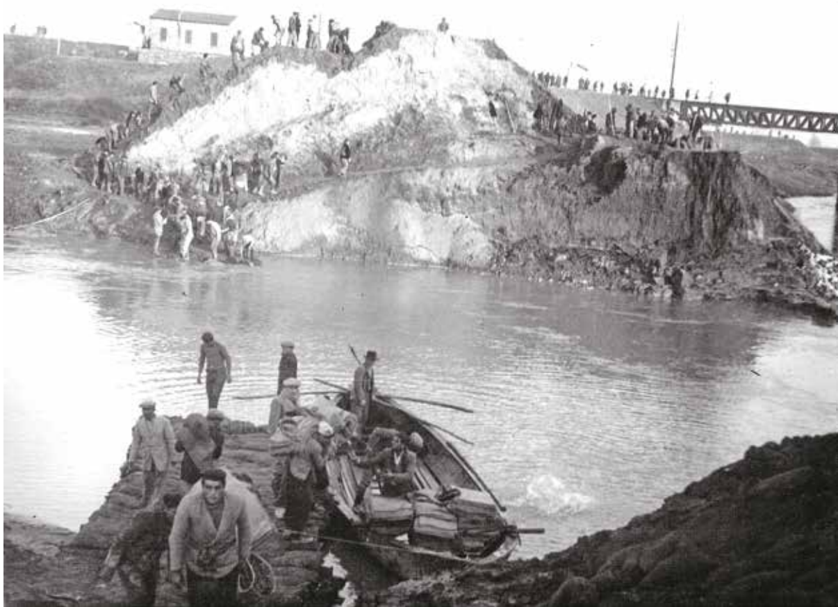
Alluvione del 1952: la coronella di tamponamento
