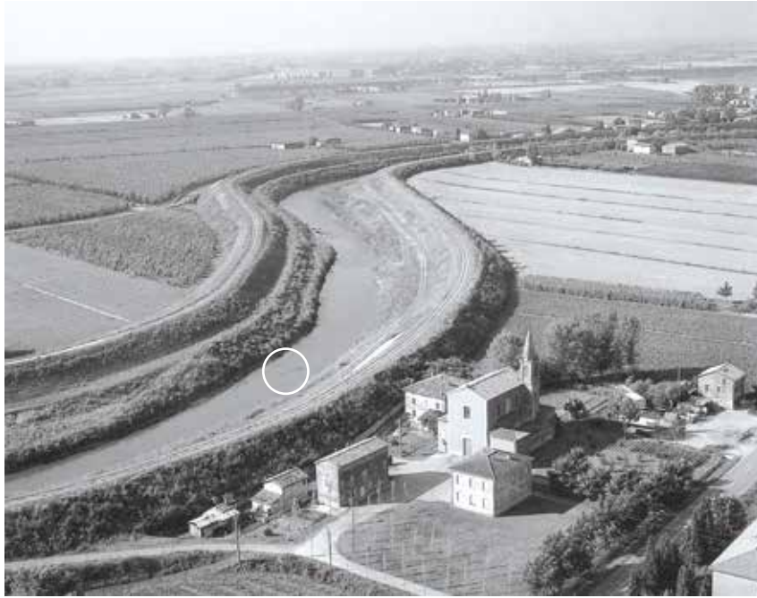
Localizzazione dei ruderi della torre sommersa in Panaro, posti in prossimità dell'abitato di Cadecoppi (Da una pubblicazione degli anni '80 del Novecento)
