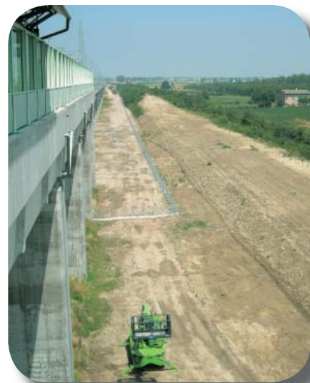
Lavori sotto il viadotto
